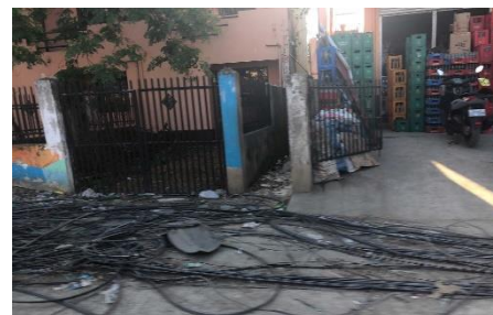
《切れた電線が地面に落下している様子》
